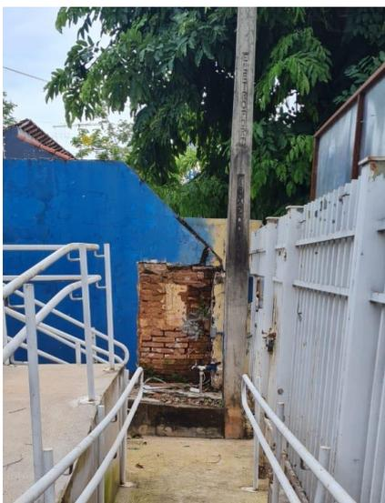
Recomendação: Executar chapisco, novo emboço, reboco, pintura e instalar o rufo com pingadeira sobre o muro.
