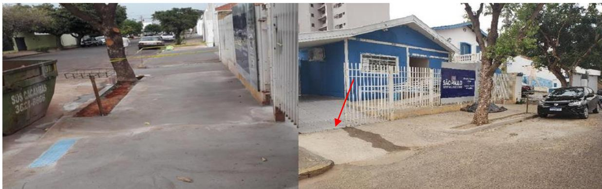
Recomendação: demolir a entrada da calçada, e piso cerâmico, execução de piso em concreto armado, Conforme itens contemplados em planilha.
