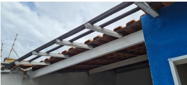
Recomendação: Instalação de calha e rufos e telhas faltantes, fechamento de alvenaria para construção de sala de reunião.
