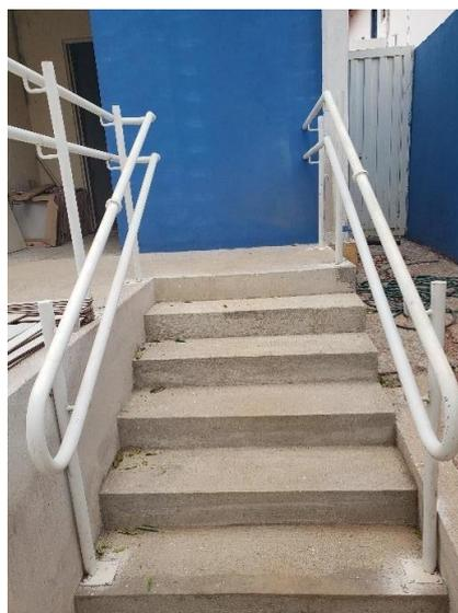
Recomendação: executar balizamento da escada, acessórios de acessibilidade conforme Norma 9050/2020.
