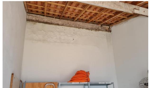
Recomendação: apicoar toda a superfície do parede, executar novo reboco, pintura e instalar a calha o rufo com pingadeira sobre o telhado eliminando toda infiltração.
