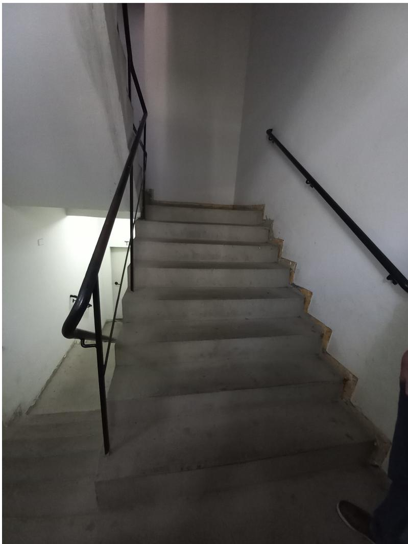
Figura 5: O corrimão que fica entre o vão das escadas é fixado através de barras que são embutidas nos degraus, é importante ressaltar que a partir do primeiro pavimento em diante, esse padrão irá se repetir.
