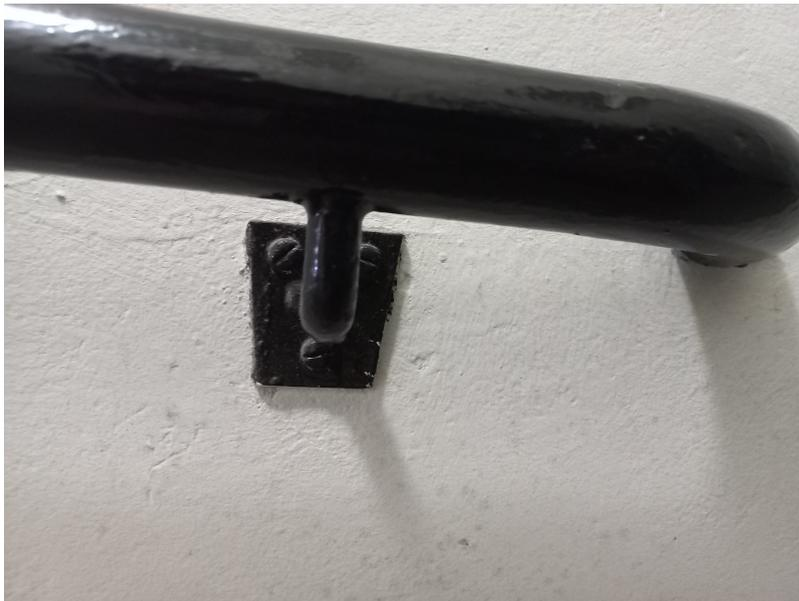
Figura 4: Os dois pontos de fixação, é composto por 3 parafusos com bucha.
