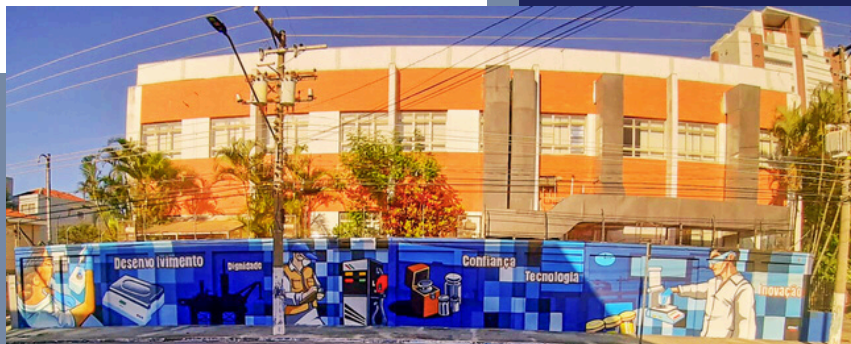
Fachada lateral do Centro Tecnológico do Ipem-SP Rua Visconde de Pirajá, Zona Sul - São Paulo / SP
